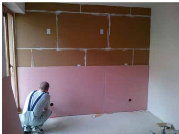
Kontaktní systém W 40 s tloušťkou pouze 40 mm je nejčastěji montovanou variantou na stěny. Finální vrstvu tvoří deskový materiál, který lze libovolně upravit, např. naštukovat nebo vymalovat
