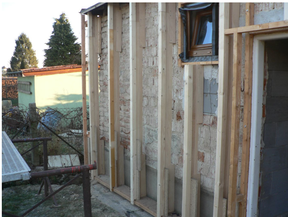
Obr. 2 - Instalace expanderů na stávající fasádu včetně vyrovnání.
