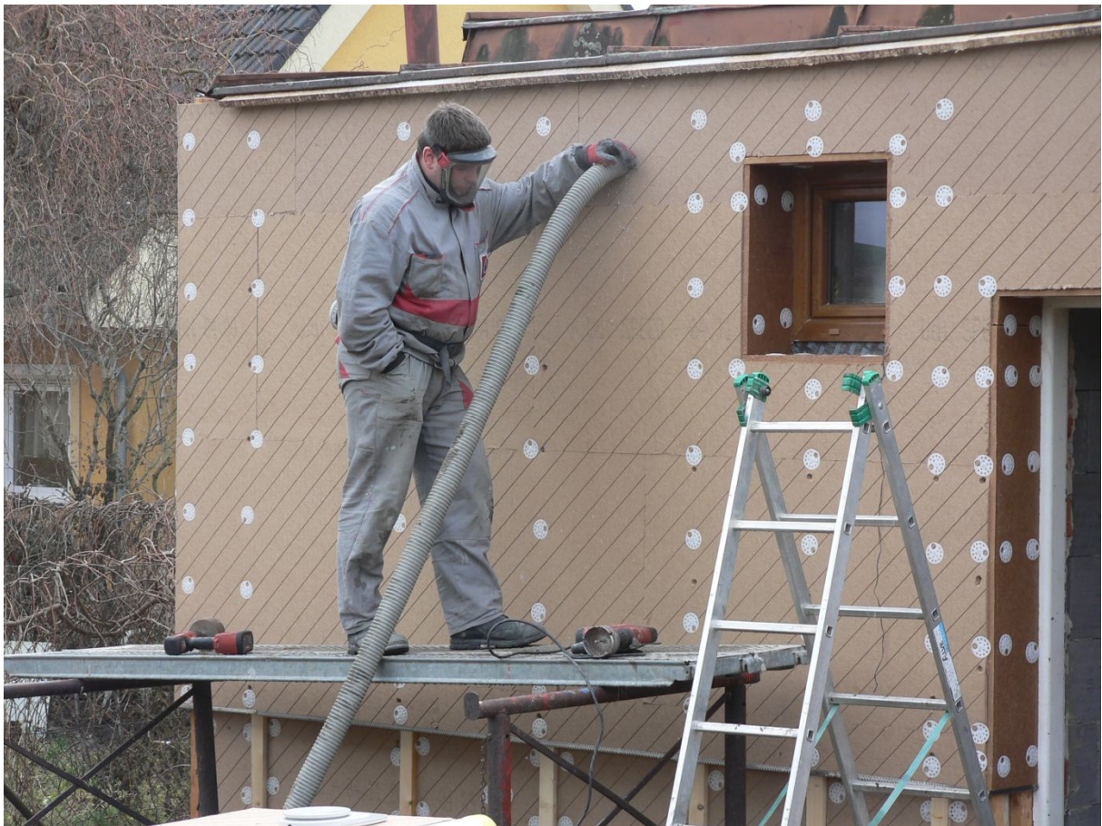
Obr. 4 - Aplikace foukané celulóznové izolace do izolačního prostoru kapsy.
