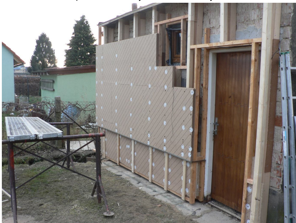
Obr. 3 - Montáž dřevovláknitých desek jako podklad pro omítku.
