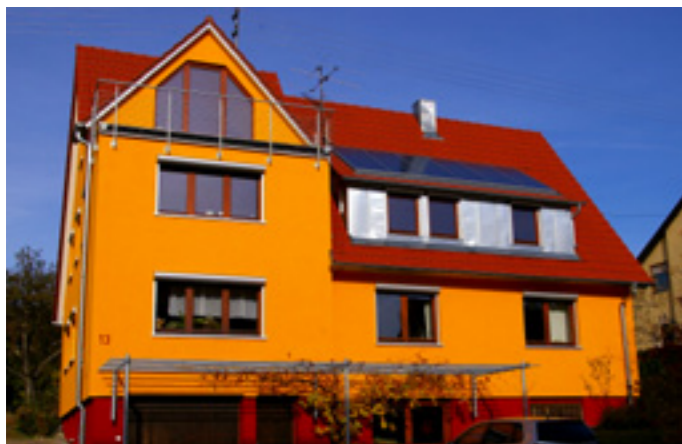
Finální úprava systému Udi SPEED® včetně omítky použité při dodatečném zateplení domu
