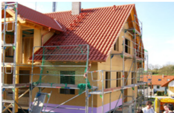
Fasáda tvořená systémem Udi SPEED® před natažením omítkového systému
