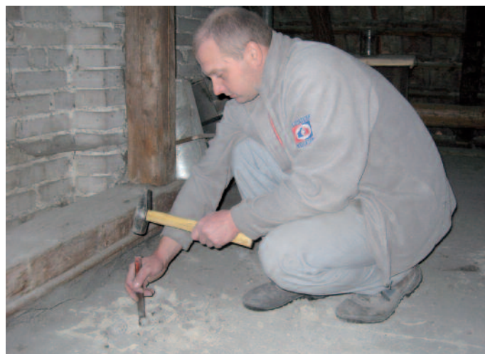
Vysekávanie krycej vrstvy po dosky záklopu.
