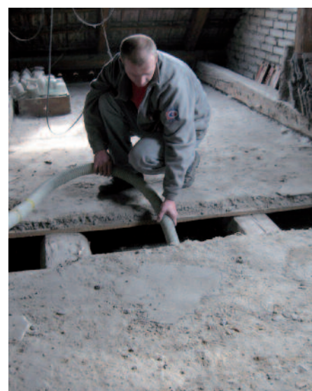
Aplikácia tepelnej izolácie CLIMATIZER PLUS nafúkaním do izolovaného prostredia.
