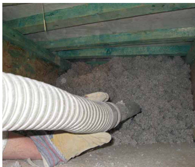
Po zafoukání se vytvoří z jednotlivých vláken deska přesně na míru prostoru. Materiál je lehký a nezatežuje nadměrně starší stropy.
