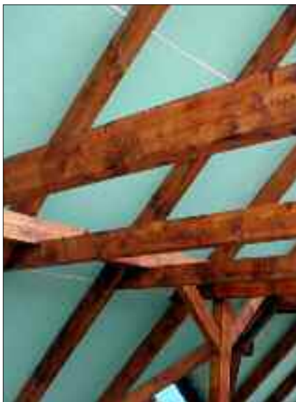
Jedním z přínosů nadkroevní izolace je větší vnitřní prostor v podkroví. Thermodach.
