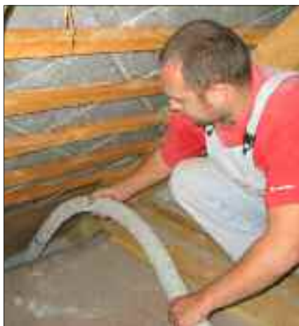
Pro vstup do konstrukce stačí odtržení jednoho prkna a následně lze konstrukci plnit celulózu. Ciur.
