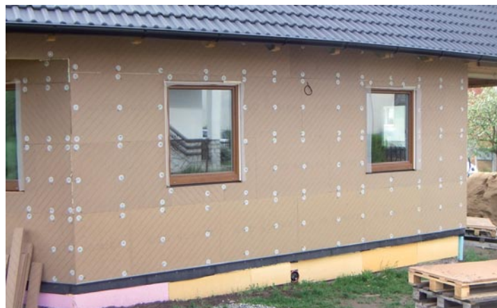
MONTÁŽ SYSTÉMU UdiSPEED® – STĚNA
