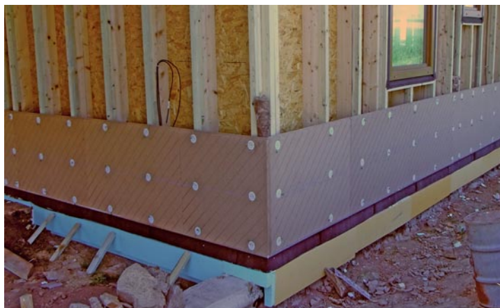
MONTÁŽ SYSTÉMU UdiSPEED® – DETAIL
