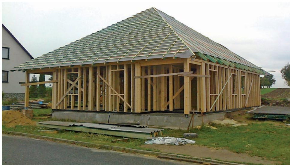
RÁMOVÁ KONSTRUKCE DŘEVOSTAVBY
