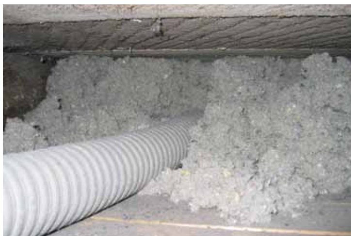
Pohled na způsob práce při dodatečném zateplování staršího stropu vyplňovaného izolací Climatizer Plus.
