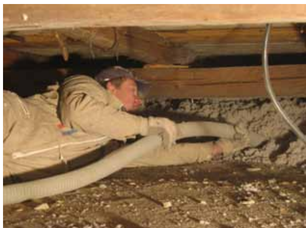
Pohled na způsob práce při dodatečném zateplování staršího stropu vyplňovaného izolací Climatizer Plus.
