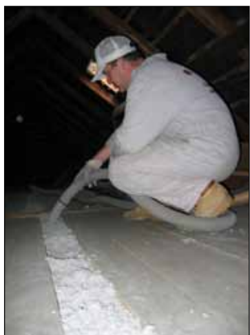
Pohled na způsob práce při dodatečném zateplování staršího stropu vyplňovaného izolací Climatizer Plus.
