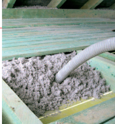
Zafúkavanie vodorovnej konštrukcie podkrovia, ľudovo – klieštin.
