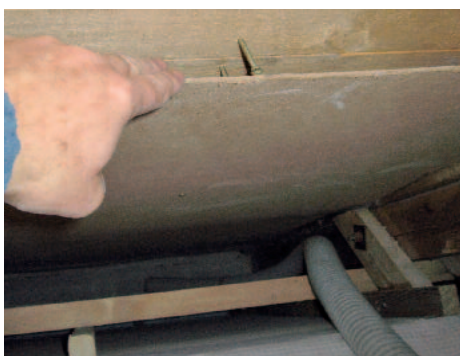
Odvetravanie vytvorené drevovláknitou doskou.
