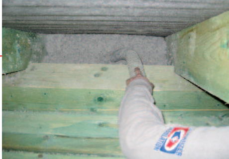
Aplikácia do šikmej časti s použitím kontaktnej paropriepustnej strešnej fólie.
