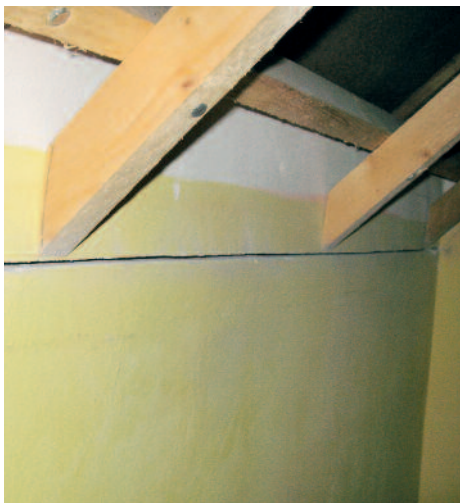
Detaily umiestnenia parobrzdza proclima INTELLO PLUS v napojení s existujúcou stenou.
