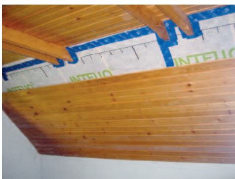
Detail umiestnenia parobrzdza proclima INTELLO PLUS.
