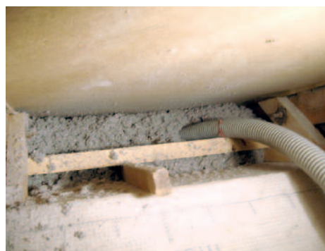
CLIMATIZER PLUS aplikovaný do rekonštruovaného podkrovia.
