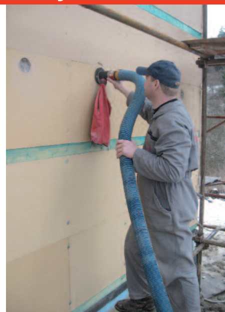
Vyplnenie dutiny obvodového plášťa.
