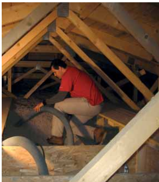
Aplikácia masívnej hrúbky 35 cm tepelnej izolácie CLIMATIZER PLUS na stropnej konštrukcii rodinného domu.
