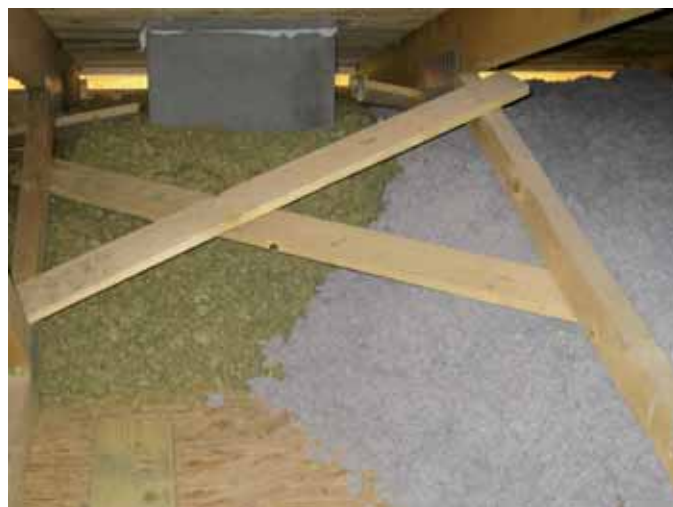
Kombinácia CLIMATIZER PLUS a CLIMASTONE – protipožiarne opatrenie stropných konštrukcií so živými kominovými telesami.
