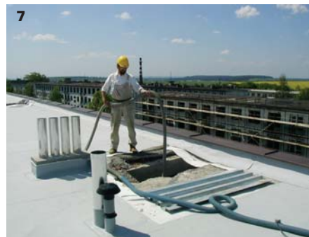
Obr. 6, 7, 8: Aplikace do střechy se provádí hadicí připojenou k aplikačnímu stroji až do výšky 30 m. Aplikační otvor může být uzavřen odvětrávací pasivní nebo aktivní hlavicí. Zvýšení a rozšíření komínku aktivní hlavicí znižuje rychlost proudění a přispívá k rovnoměrnému nasávání vzduchu z dutiny
