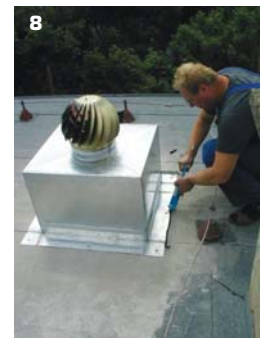
Obr. 6, 7, 8: Aplikace do střechy se provádí hadicí připojenou k aplikačnímu stroji až do výšky 30 m. Aplikační otvor může být uzavřen odvětrávací pasivní nebo aktivní hlavicí. Zvýšení a rozšíření komínku aktivní hlavicí znižuje rychlost proudění a přispívá k rovnoměrnému nasávání vzduchu z dutiny
