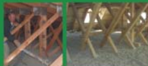
Aplikace na horizontálních konstrukcích rychlá a dokonalá v detailech.
