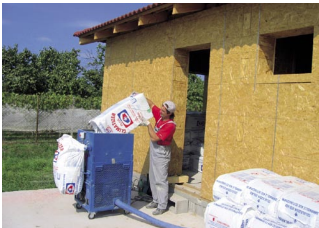
Jednoduchá manipulácia s izolačným materiálom, plnenie aplikáčného zariadenia.
