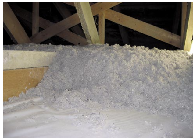
Použitie vyšších hrúbok pri aplikácii na vodorovné konštrukcie sú samozrejmosťou pri nízkoenergetických stavbách.
