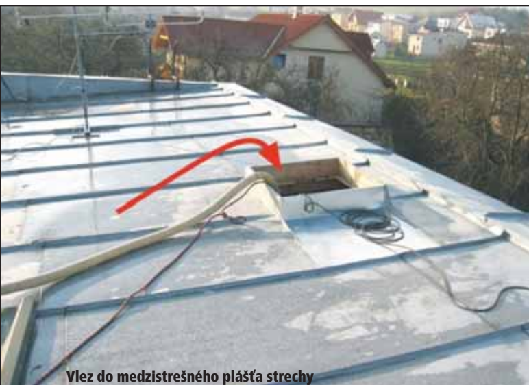
Medzistrešný priestor dvojplášťovej strechy s izoláciou
