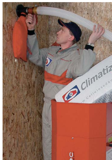
Obr. 3: Metoda plnění panelů ve svislé pozici
