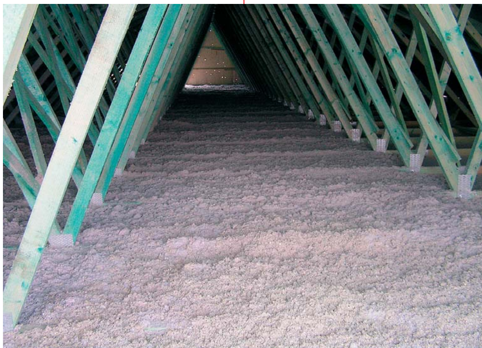
Obr. 1: Aplikace na podhledu ve styčnickové konstrukci
