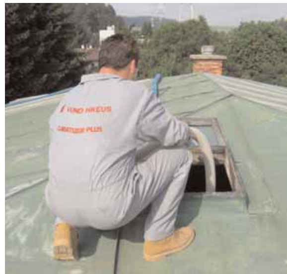
Dodatečná aplikace izolace do stanové střechy – nepochozí půdní prostor.
