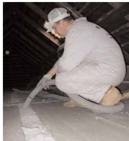
Plnění stropu, z prostoru půdy, mezerou po odtržení jednoho ze záklopových prken. Vyplnění je možné do vzdálenosti asi 3 m
