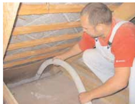
Dodatečné zateplení šikmých částí střechy. Vzduchová mezera nad izolací je vymezena zasunutím dřevovláknité difuzně otevřené desky s vymešovými latěmi pro odvětrání
