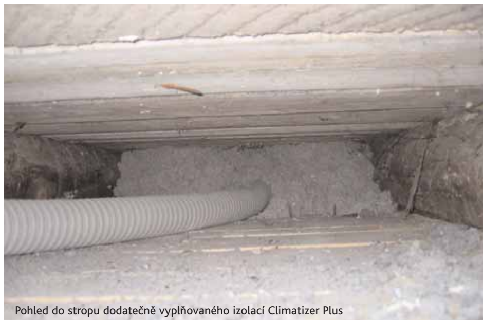
Plnění stropu, z prostoru půdy, mezerou po odtržení jednoho ze záklopových prken. Vyplnění je možné do vzdálenosti asi 3 m
