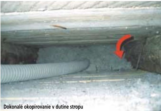
Odstránenie záklopovej dosky pre aplikáciu tepelnej izolácie CLIMATIZER PLUS
