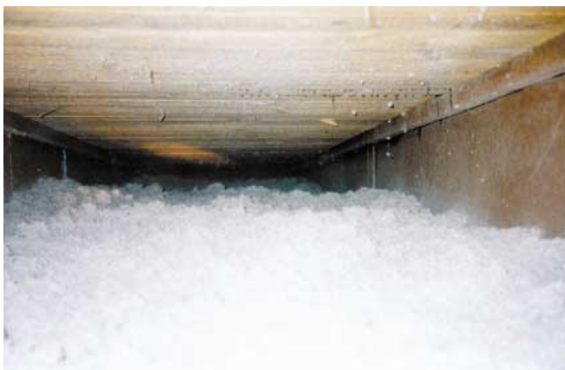
▲ Dvojplášťová strecha z lepenkových väzníkov – po doizolovaní medzistrešného priestoru. "Fúkaná" celulózová izolácia postupne vyplní priestor a dokonale prilne k strešnej konštrukcii
