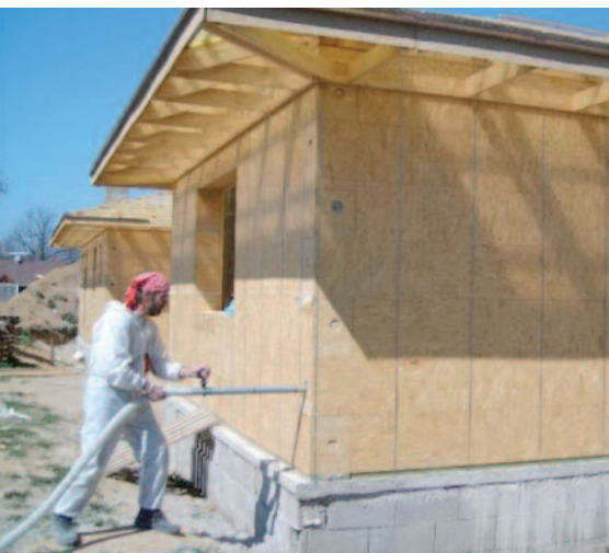
Segmentová drevostavba, aplikácia s vysokou objemovou hmotnosťou.
