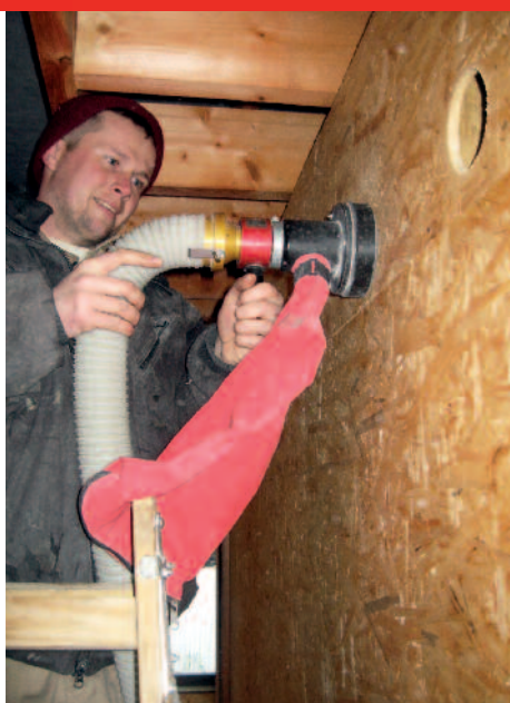
Aplikácia do kolmej konštrukcie drevostavby.
