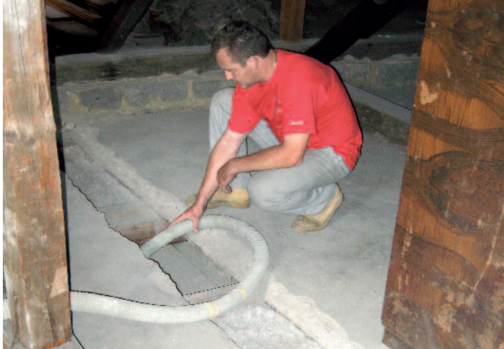
Aplikácia do dutiny stropu; izolovaná plocha cca 70 m 2 , výška trávov cca 18 cm – výstavná cena 818,- € (24.643,07 Sk), aplikovaných 39 ks vriec.
