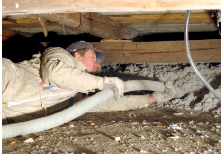
Aplikácia v dvojplášťovej streche; izolovaná plocha cca 90 m 2 , hrúbka izolácie 15 cm – výstavná cena 790,- € (23.799,54 Sk), aplikovaných 35 ks vriec.
