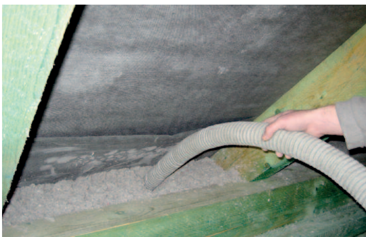
Aplikácia do šikmej časti nového podkrovia; izolovaná plocha cca 50 m 2 , hrúbka izolácie 20 cm – výstavná cena 839,- € (25.275,71 Sk), aplikovaných 40 ks vriec.
